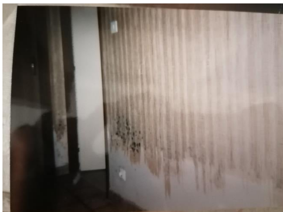
Figure 16 : Exemple de photo transmise par les propriétaires au moment du diagnostic
