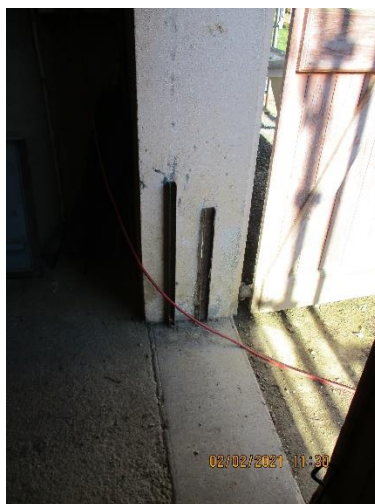
Figure 18 : Exemple de protection déjà en place
